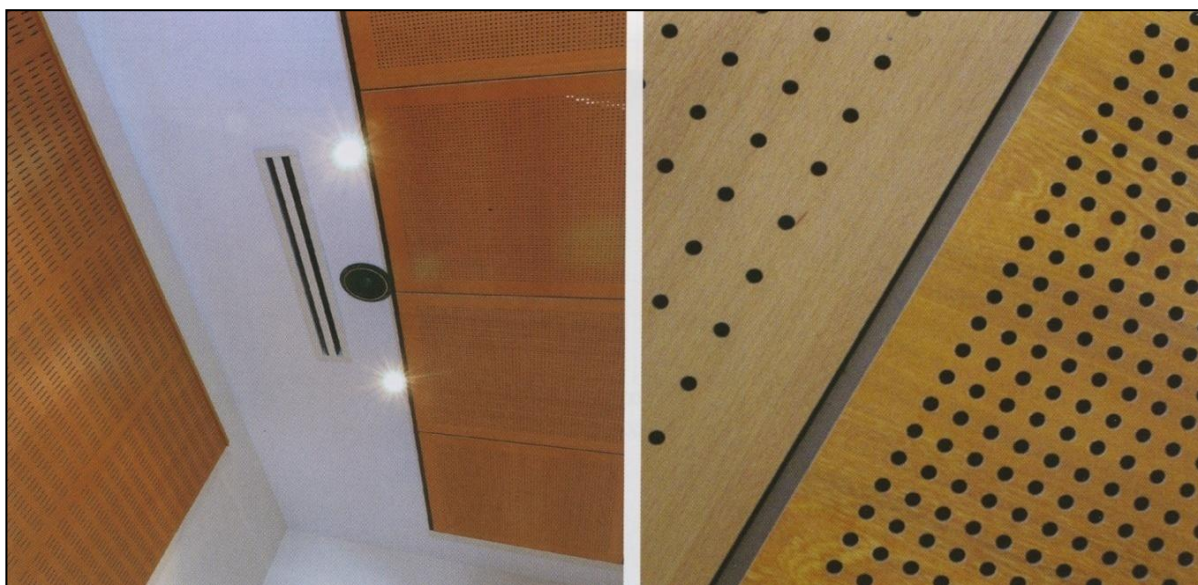
Obr. 1.4 Možné provedení děrovaných desek a příklad jejich použití v praxi [2]
