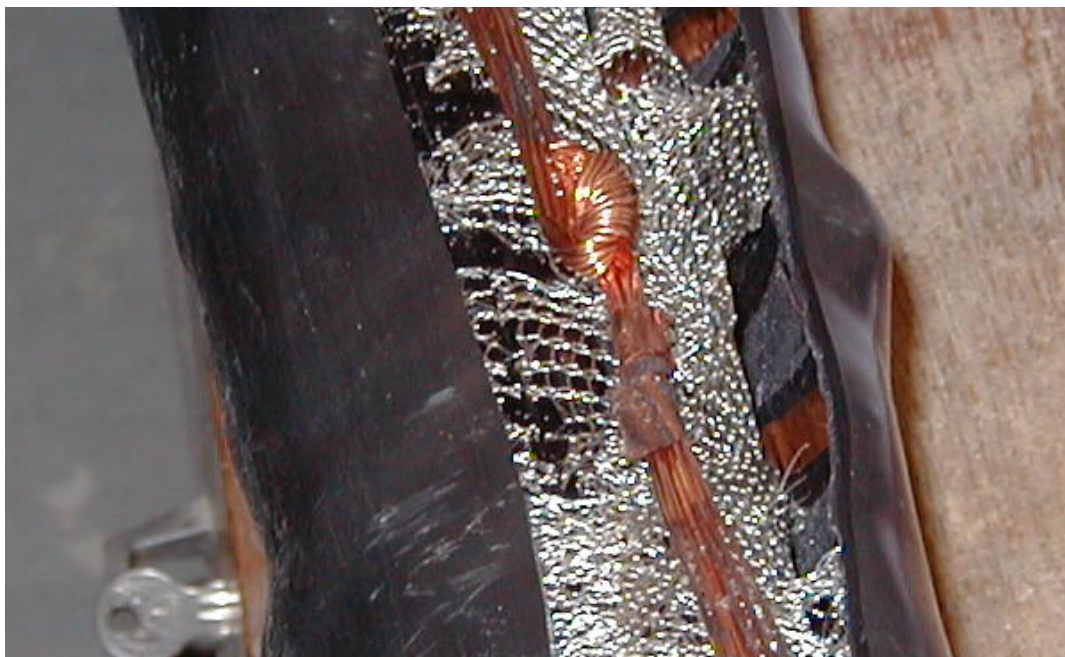
Obrázek 2: Spojení stínění kabelů
