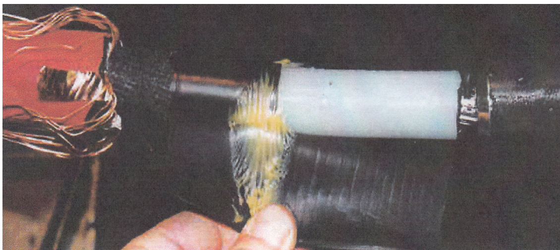
Obrázek 3: Ostré hrany po odstranění polovodiivé vrstvy
