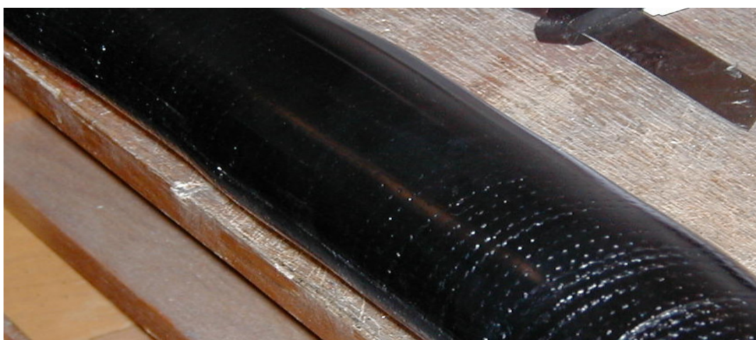
Obrázek 3: Nedostatečně smrštěná izolační trubice
