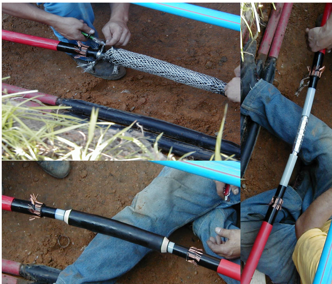
Obrázek 2: Postupný rozbor spojky
