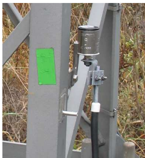
Obr. 16 Ochrana ukolejněním přes UPO
