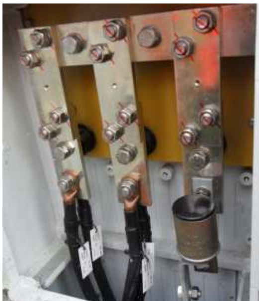
Obr. 20 Uzemnění zpětných vodičů přes UPO
