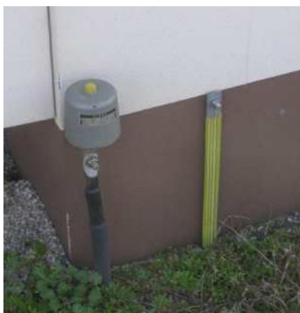
Obr. 15 Ochrana uzemněním a nepřímým ukolejněním
