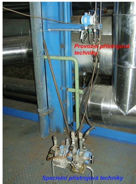
Obr. 1.10 Paralelní připojení k provoznímu měření
