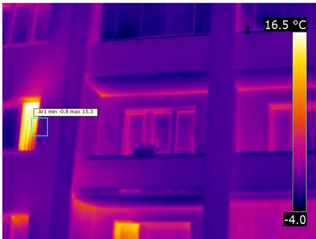
Obrázek 2.2 – Lodžie – jižní strana domu
