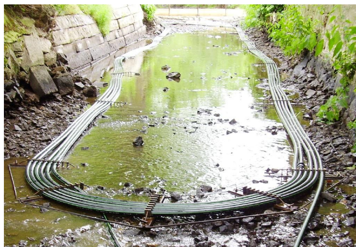
Obr.3.2.2-8 Trubky kolektoru položené na dně potoka (převzato z [42])
