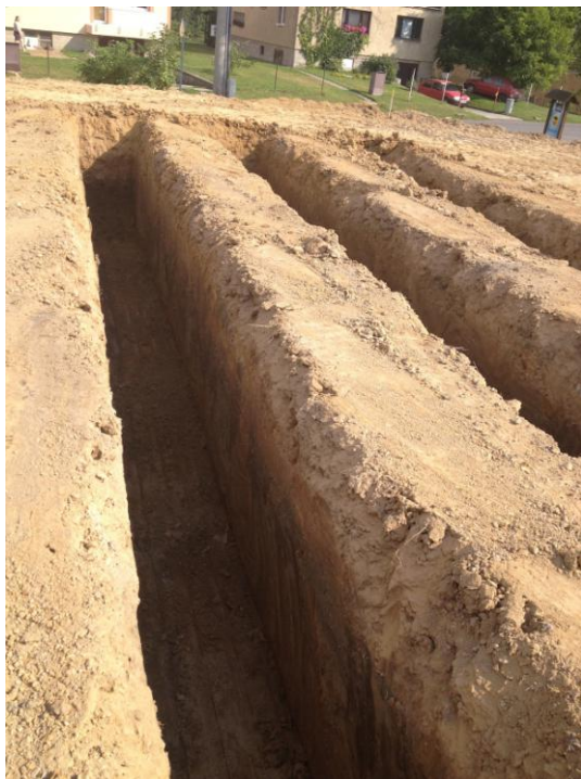
Obr.3.2.2-11 – Výkop pro plošný kolektor
