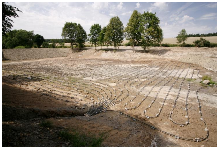
Obr.3.2.2-6 – Kolektor položený na dně rybníka (převzato z [42])
