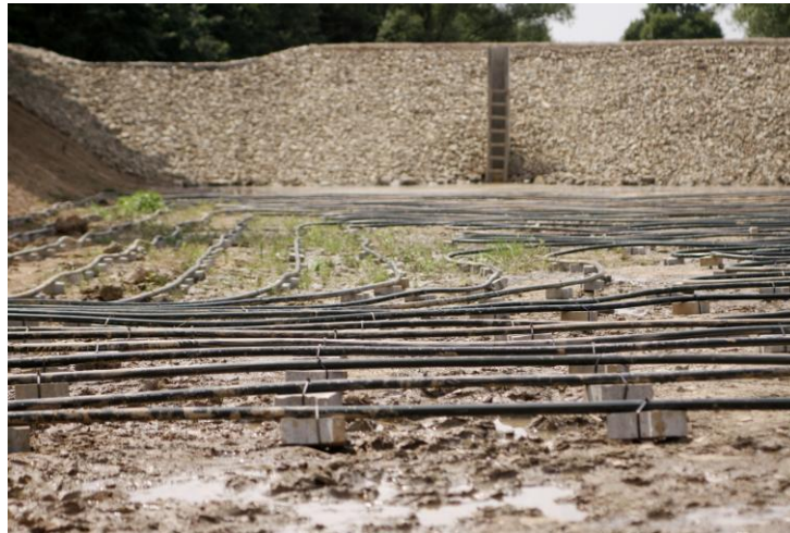
Obr.3.2.2-7 – Položené trubky kolektoru v rybníce – detail (převzato z [42])
