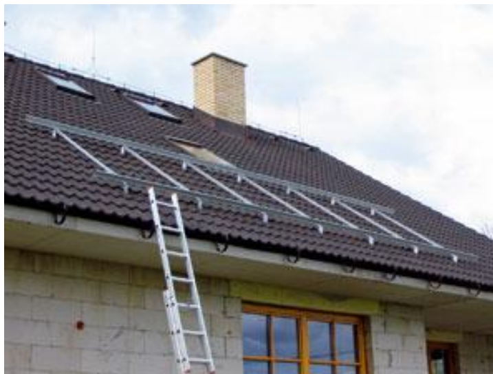
Obr. 3.2.3-12 – Podstavce pro upevnění kolektorů (převzato z [63])
