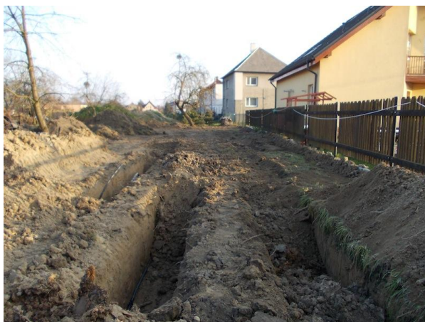
Obr.3.2.2-13 – Zahřnování výkopu (převzato z [50])
