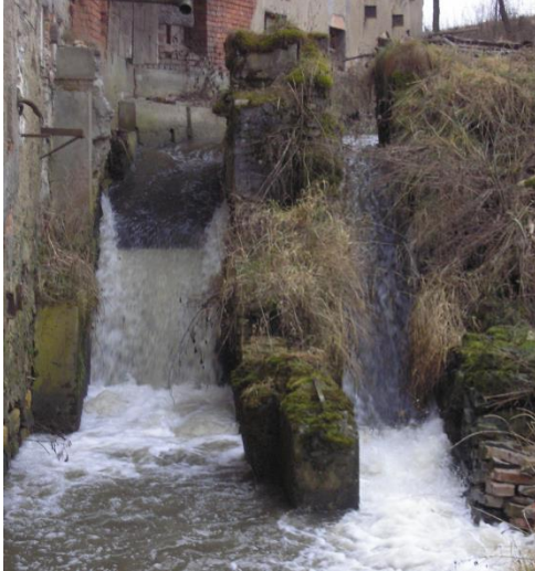
Obr. č. 11: Hlavní jez současný stav
