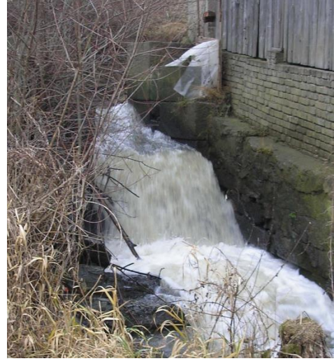
Obr. č. 12: Odlehčovací jez současný stav
