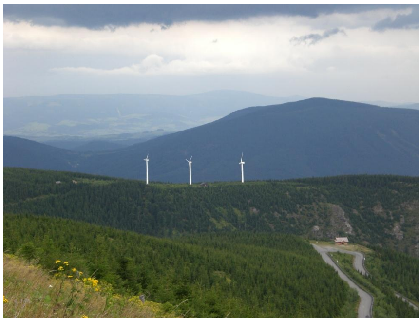
Obr. 5.2-2 Větrné elektrárny na hoře Mravenečník
