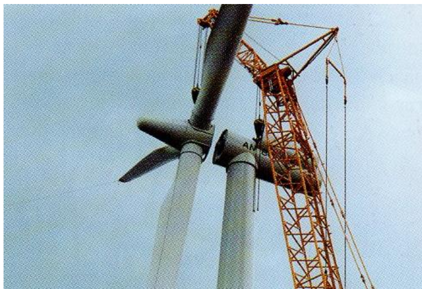
Obr. 1.4-1 Montáž rotoru ke gondole (přejato z [2])
