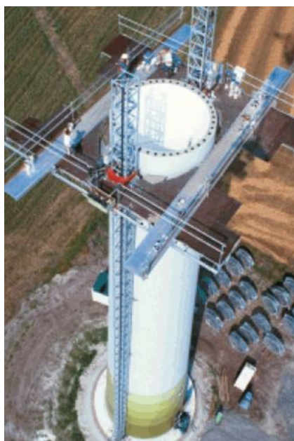
Obr. 1.2-3 Prefabrikovaný stožár (přejato z www.csve.cz )
