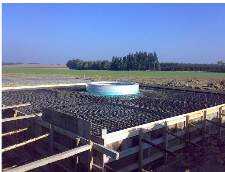
Obr. 1.1-1 Výztuha betonového základu (přejato z www.csve.cz )
