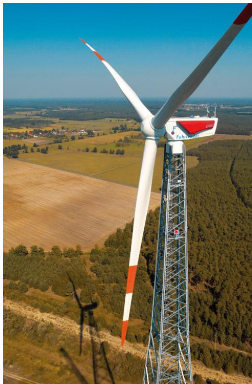
Obr. 1.2-2 Příhradový stožár (přejato z www.csve.cz )
