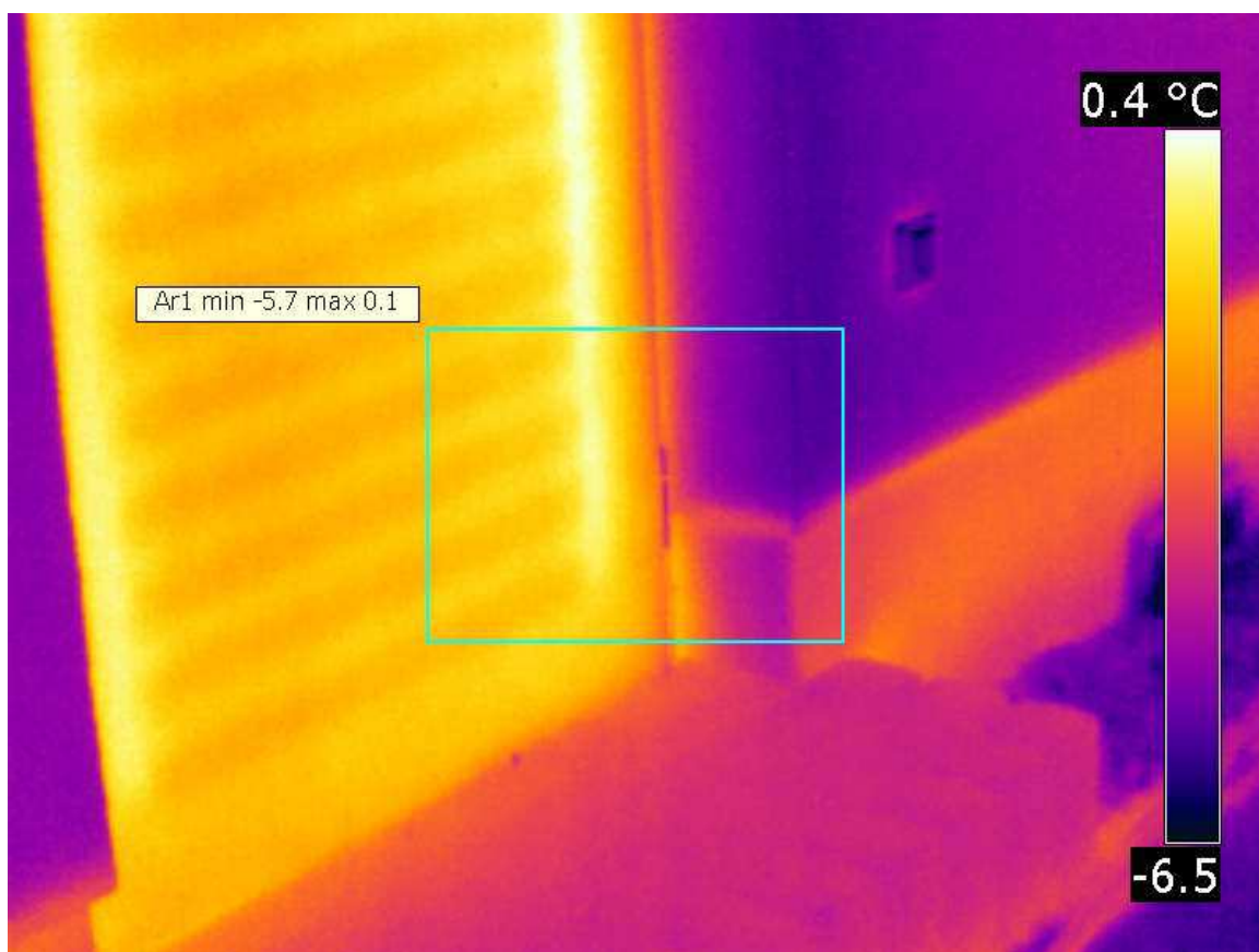
Obrázek 3.5: Snímek z měření termokamerou 3
