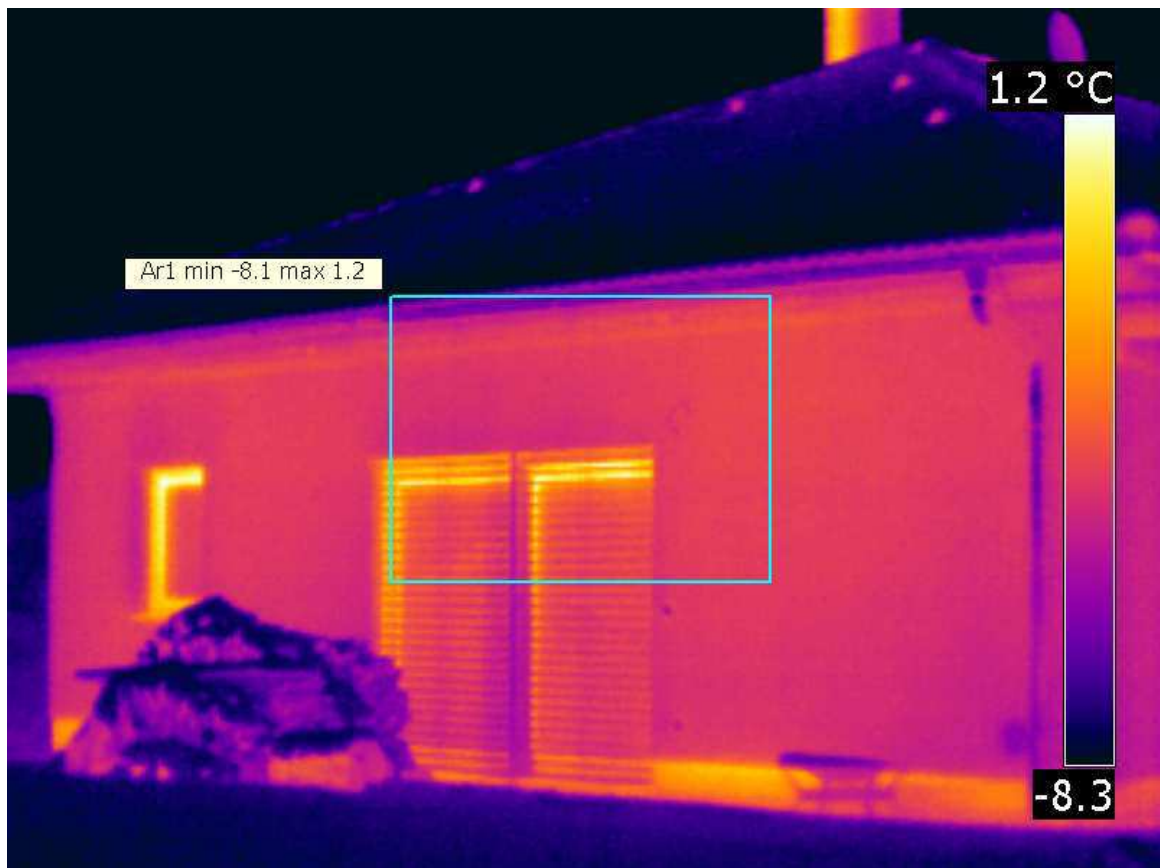
Obrázek 3.7: Snímek z měření termokamerou 5
