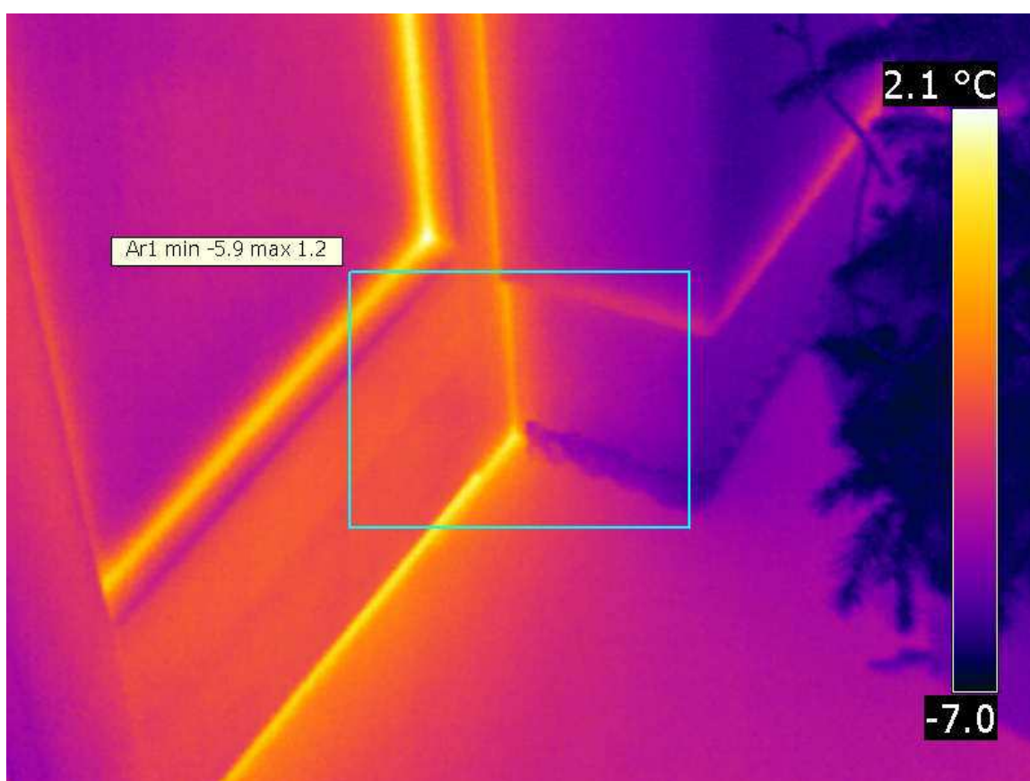
Obrázek 3.4: Snímek z měření termokamerou 2
