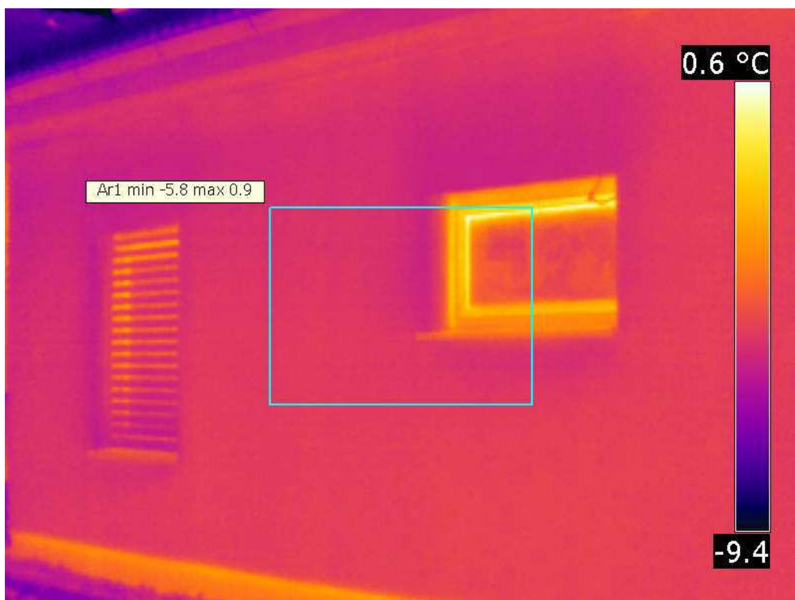
Obrázek 3.3: Snímek z měření termokamerou 1
