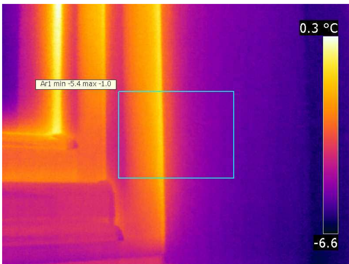
Obrázek 3.6: Snímek z měření termokamerou 4
