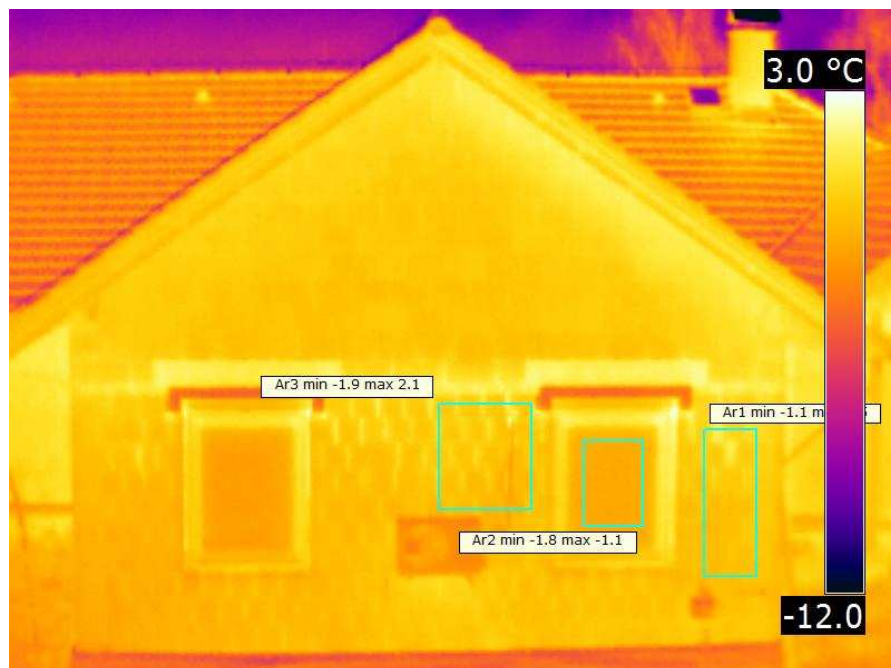
Obr. 5.10 Termogram vně ref. místnosti stěna „B“, hodnoty teploty na ploše [38]
