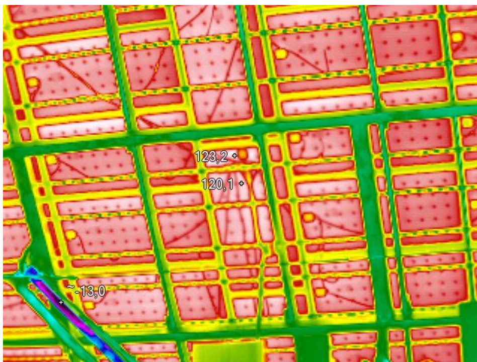
Obrázek 7 - Infračervený snímek FV panelů na FV elektrárně v Strašicích (teploty jsou ve °C)
