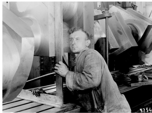
Obr.2.33 Ustavování velké klikové hřídele [16]
