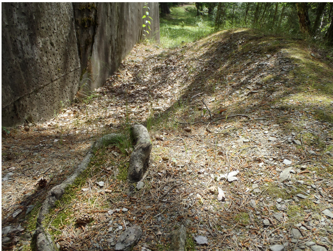
Obr. 7: Destrukce zásypu – Rabštejn nad Sřtelou
