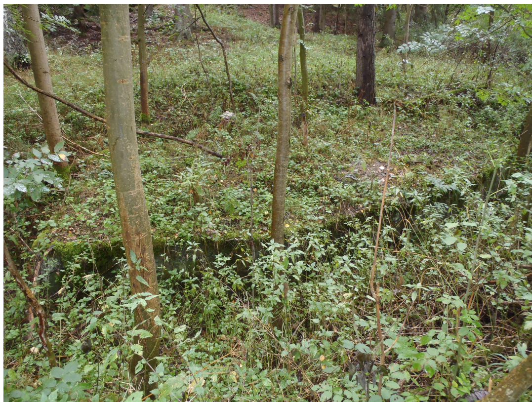
Obr. 13: Nedostavěný lehký objekt LO vz.37
