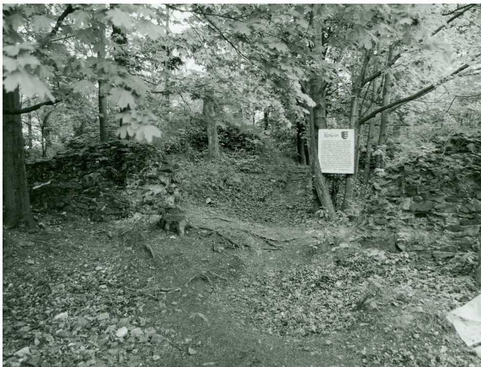
Obr. 15 – Pohled do interiéru paláce od přístupové cesty (foto p. Gryc květen 1989)
