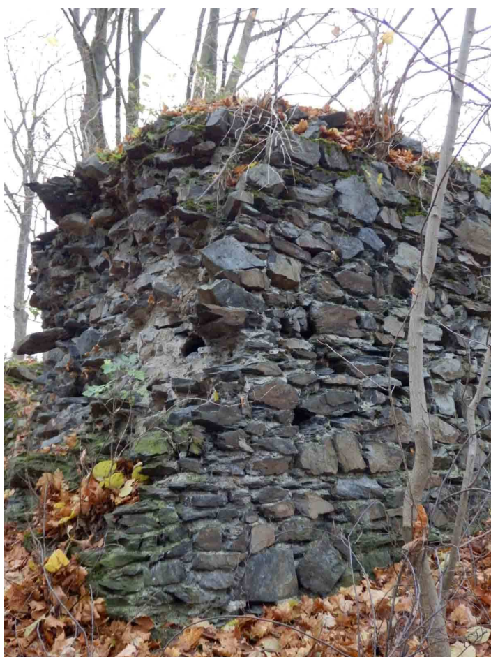
Obr. 25 – Severovýchodní nároží, na němž je dole znatelné zaoblení (foto autor)
