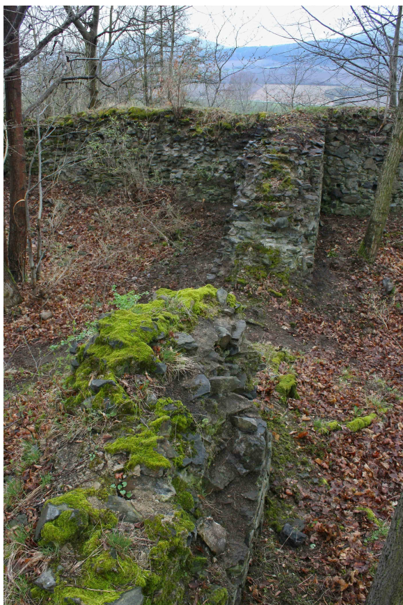
Obr. 27 – Dělicí příčka interiéru paláce, pohled od východu (foto Petr Bauer)
