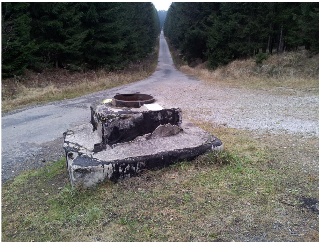
Obr. 14.29: Kabelová studna (objekt 89), foceno: 24. 11. 2012
