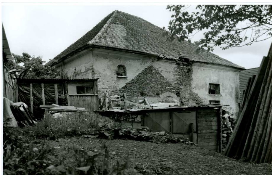
Stav z devadesátých let po stržení přístavku, je velmi dobře patrný otisk střechy a komína od pekárny macesů. Foto: Kodera (sbírka fotografií V. F. Chvátala)
