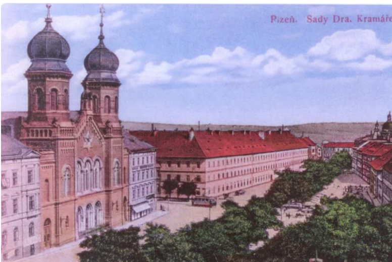
Novodobá pohlednice zachycující stav ve 20. letech 20. století v Plzni v Sadech Pětatřicátníků. Architekt Emanuel Klotz.
