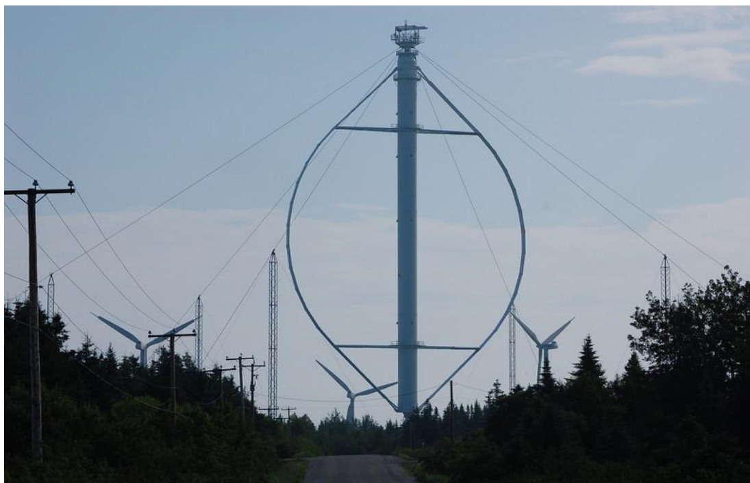
Obr. 1.4 Éole, největší větrná elektrárna se svislým rotorem, oblast Cap-Chat, Quebec, Kanada (převzato z [7])
