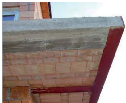
rohový balkón s nosnými prvky z válcovaných ocelových profilů
