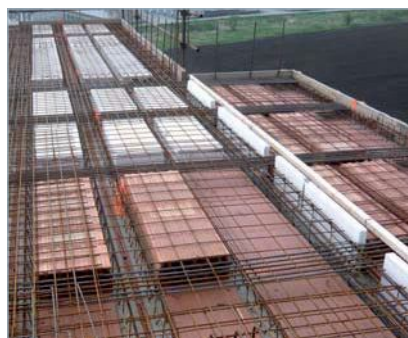
přerušení tepelného mostu mezi balkónem a stropem
