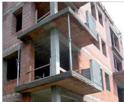
rohový balkón s přidanou výztuží
