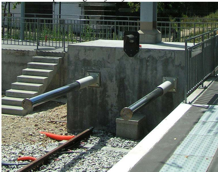
Obr. 21. Zarážedlo s tlumiči nárazu (Saint-Rémy-lès-Chevreuse, Francie) (6)
