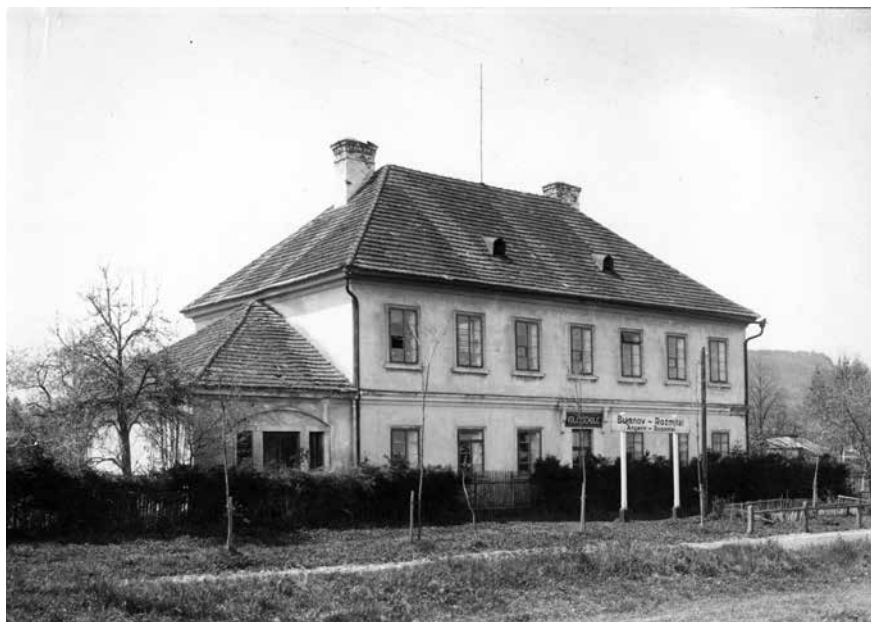
Obr. 47. Bujanov. Budova přeprahací stanice koněspřežní dráhy v roce 1925 (podle Hajn - Chvojka - Majer 2004 , obr. 1).
