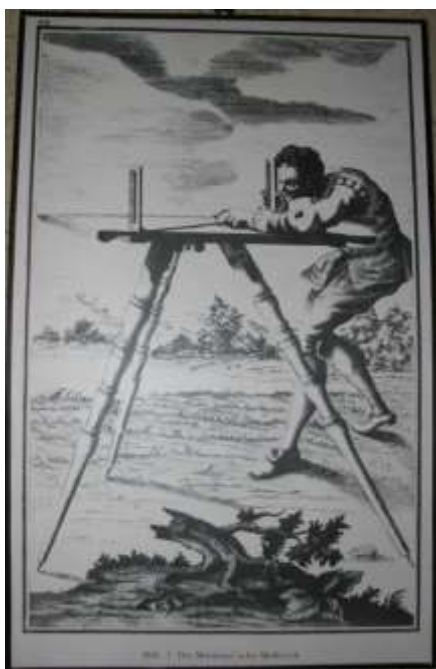
Obr. 1 Zeměměřič při práci s měřickým stolem (BEV v Rakousku).
