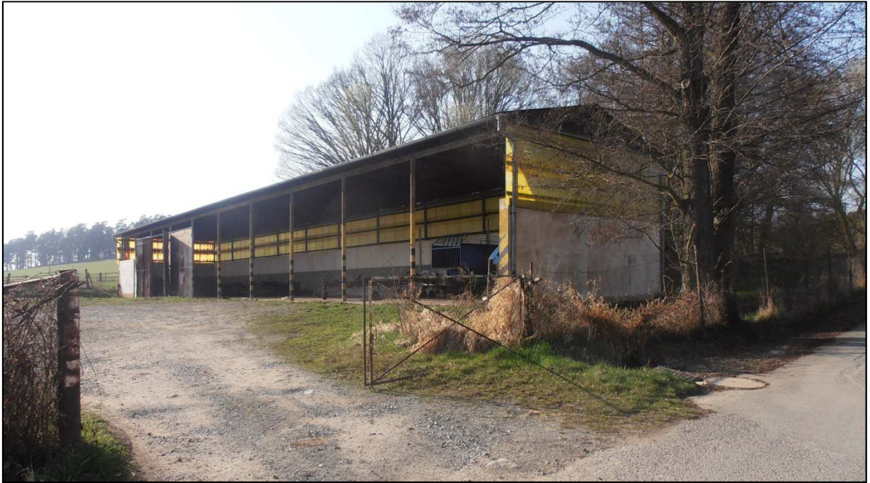
Pohledovou závadu přímo na návsi Štěnovického Borku tvoří areál zemědělského družstva. Stálo by za úvahu zkulturnění aspoň této části areálu, která kazí dojem celé návsi.
