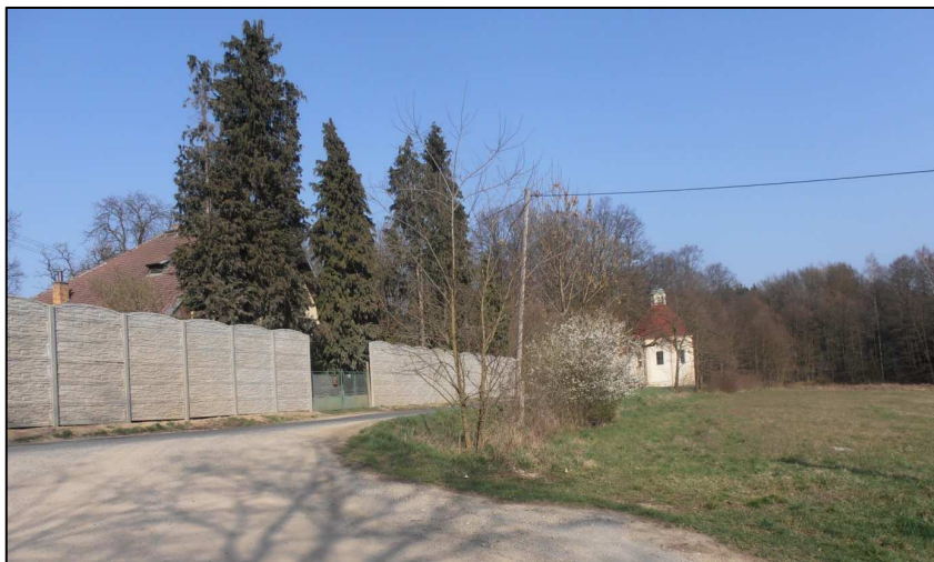
Obr. 3.3: Protihlukový plot hájovny. Lidé se báli rozšíření dobývacího prostoru lomu právě na louku naproti kapli sv. Vojtěcha.
