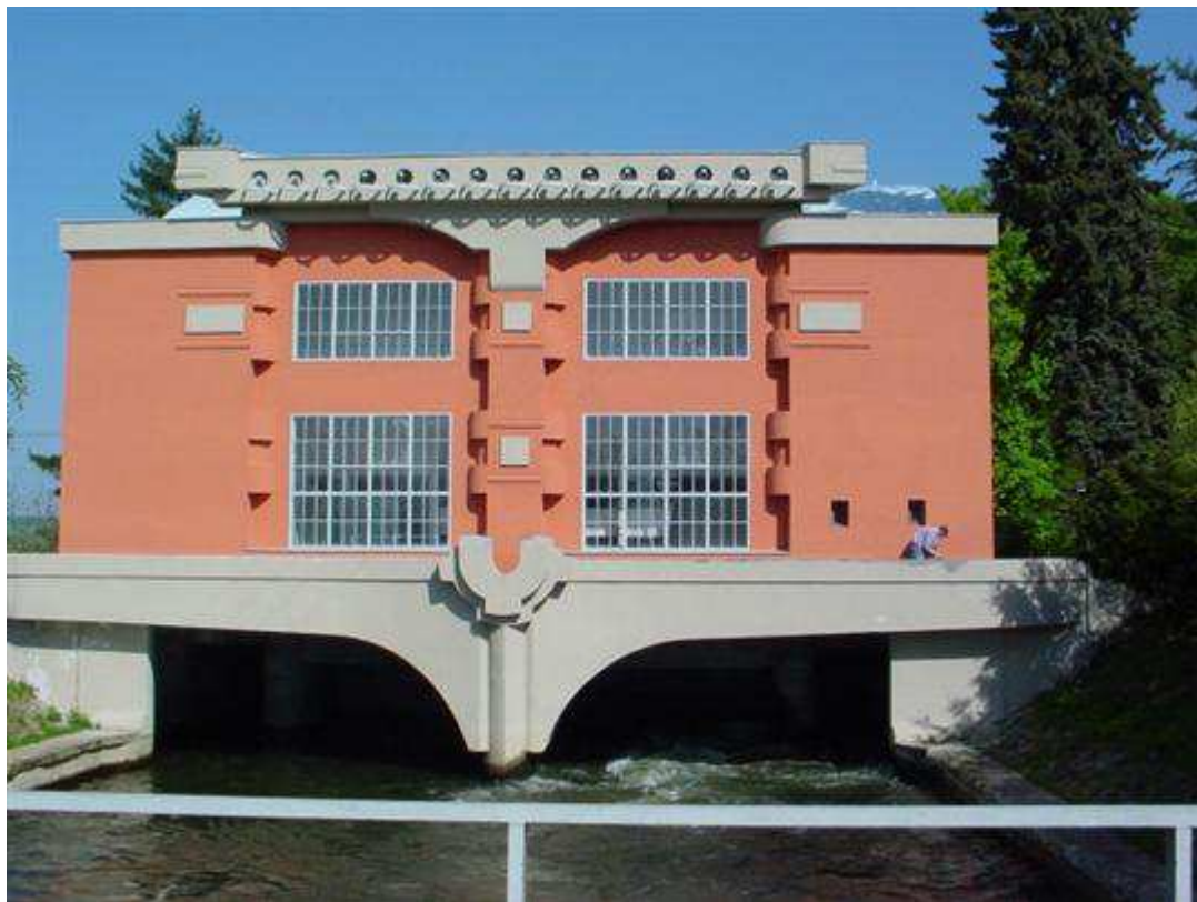
Obrázek 11 Malá vodní elektrárna Háj 20
