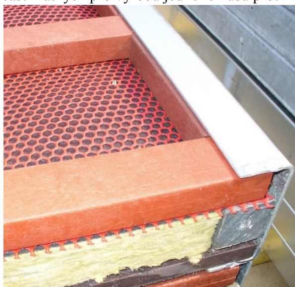
Obr. 4 – 5 Sendvičová struktura panelu PP - lať
