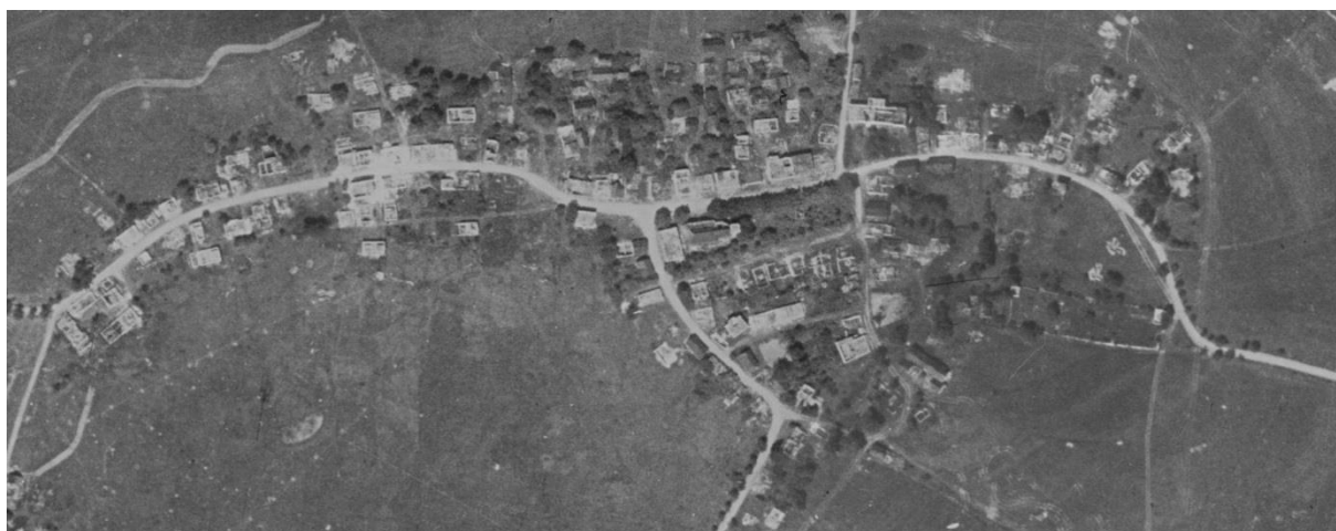
Obrázek 27: Vojenský letecký snímek zaniklé obce Čistá - 1952, následky vojenských cvičení (Zdroj.: obec Čistá – Archiv - VGHMÚř)
