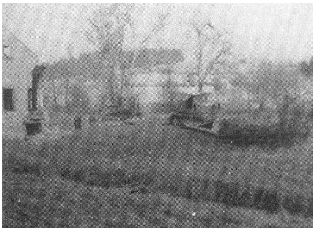
Obrázek 4: Fotografie průběhu demolice vesnice Zahájí (Waldheim) Zdroj.: (Weidensteiner – Wolfinger, 1966)
