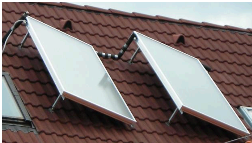
Obr. 4.1 Úprava naklonění solárního kolektoru, přejato z [8]
