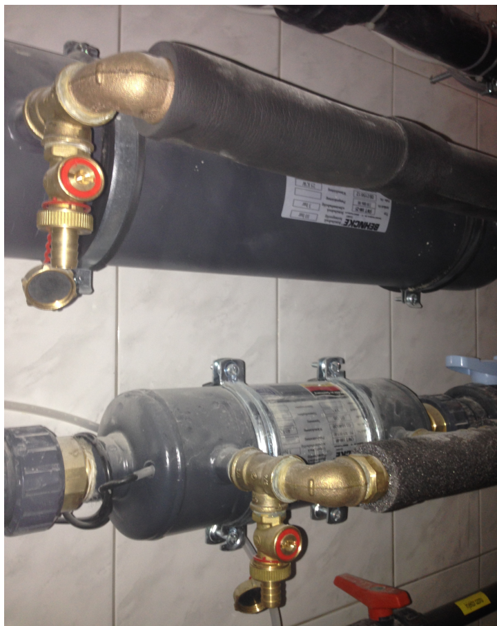
Obr. 2.8. Bazénový výměník tepla pro solární systém (spodní)
