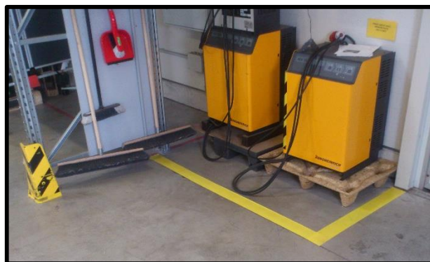
Obr. 66 Prostor pro skladování dobíjecích přístrojů pro baterie
