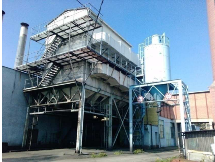
Obr. 4.9 Filtrační objekt a silo na popílek
