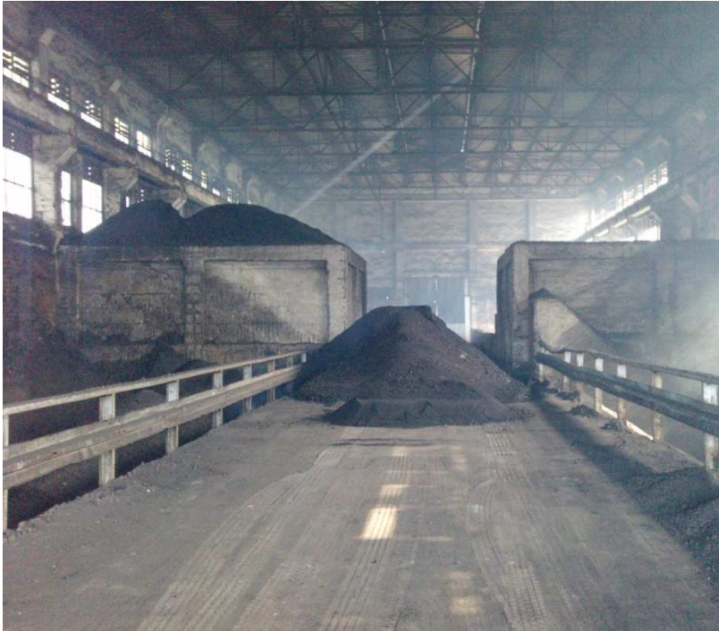
Obr. 4.3a Sklad paliva Františkolázeňské výtopny
