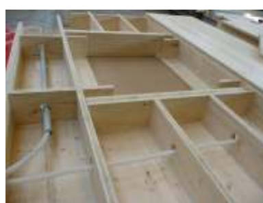
Obr. č.69- 10 Izolace v NOVATOP ELEMENTS a 11 vedení rozvodů v stropní konstrukci
