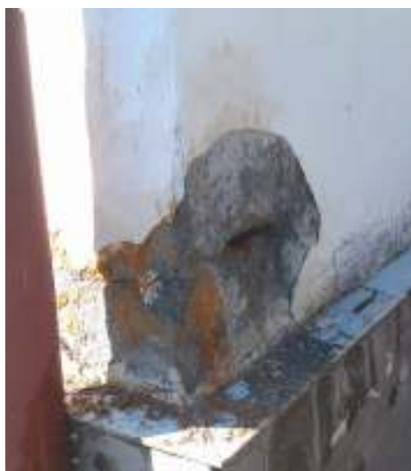
Obr. č.2 – Porušení vlivem vlhkosti v soklové části
