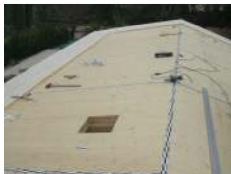
Obr. č. 70- 12 Řešení přesahů a řešení konstrukce a 13 montáž desek NOVATOP STATIC
