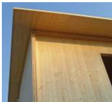
Obr. č. 70- 12 Řešení přesahů a řešení konstrukce a 13 montáž desek NOVATOP STATIC
