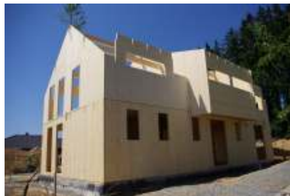
Obr. č.67- 8 Stavba ze stěnových panelů
