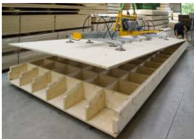
Obr. č.68- 9 Výroba stropní konstrukce – NOVATOP ELEMENTS
