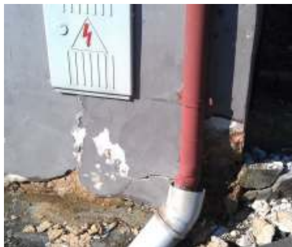
Obr. č.2 – Porušení vlivem vlhkosti v soklové části
