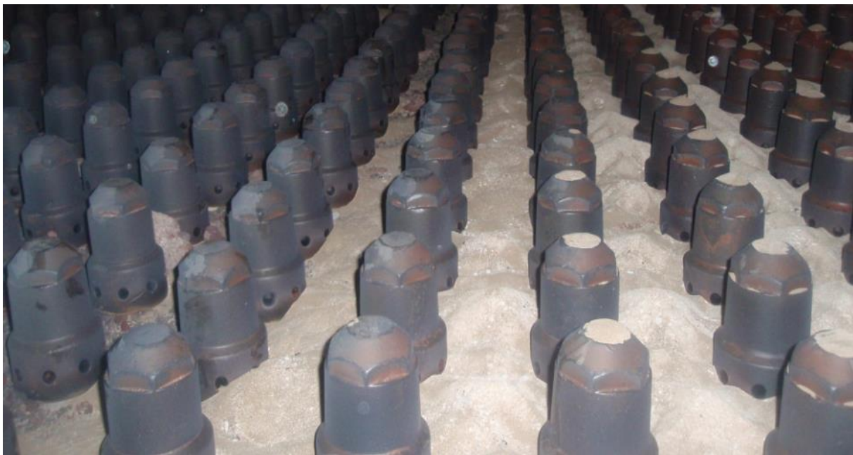
Obr. 4-3 - Spalovací komora - fluidní dno [17]
