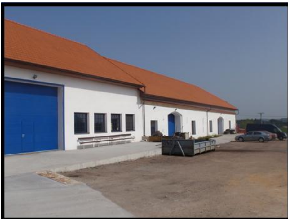
Příloha č. 21: Zrenovované hospodářské budovy a budovy, které renovace čeká 187
