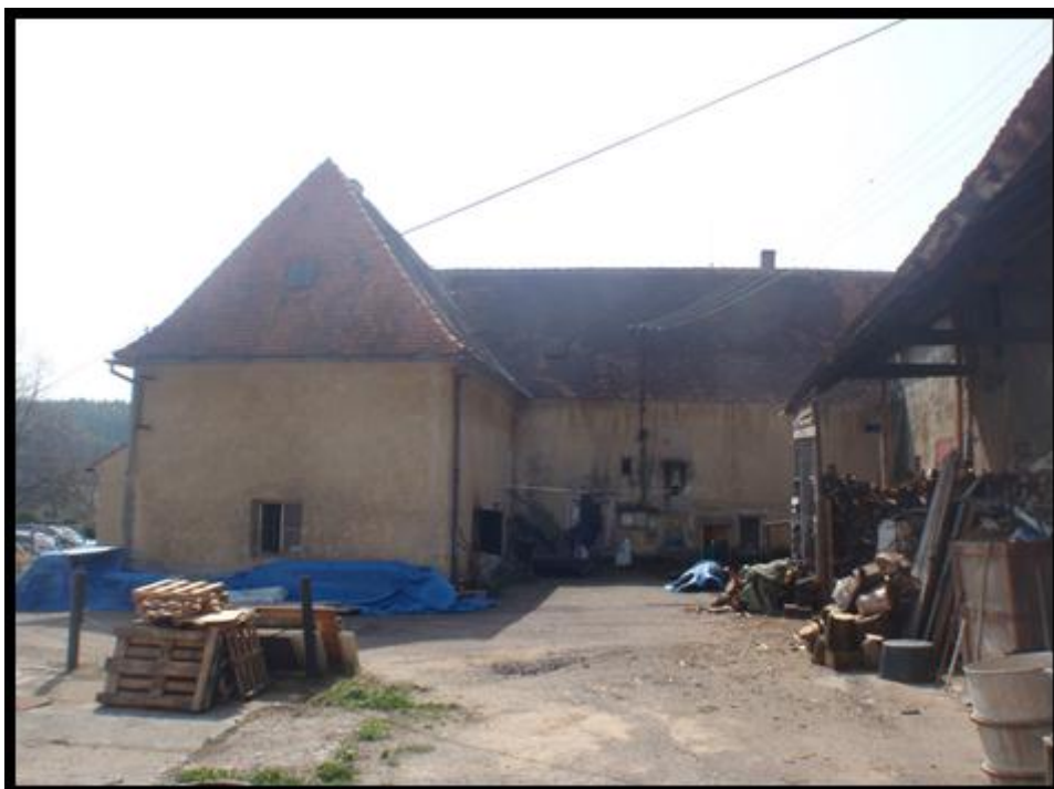
Příloha č. 16: Současný stav – pohled ze dvora I 182
