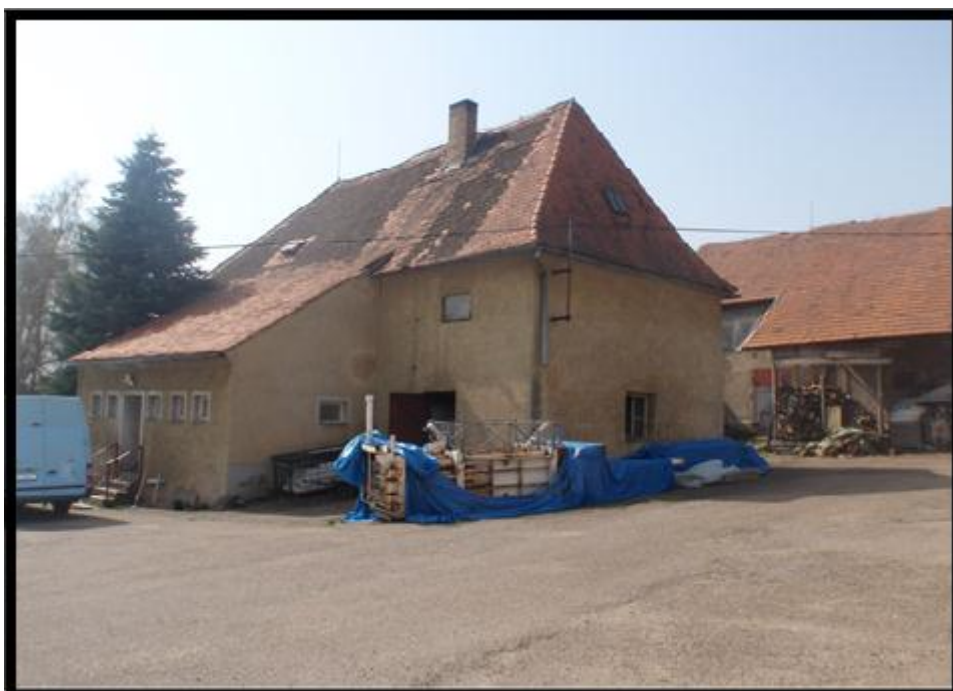
Příloha č. 17: Současný stav – pohled ze dvora II 183
