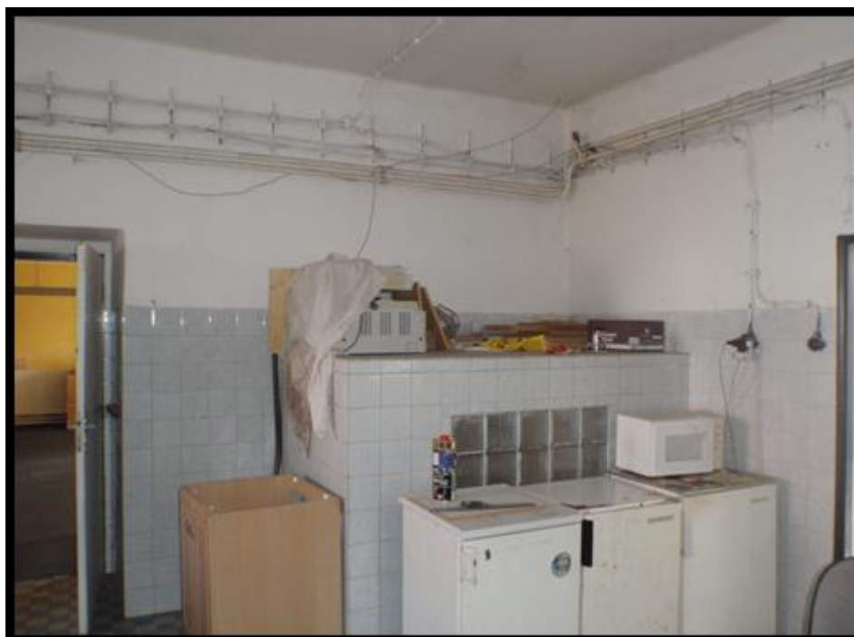
Příloha č. 19: Bývalá závodní jídelna v přízemí objektu II 185
