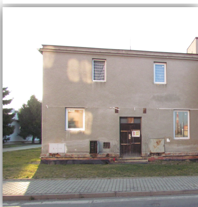
Obrázek č. 11: Budova - čelní pohled
