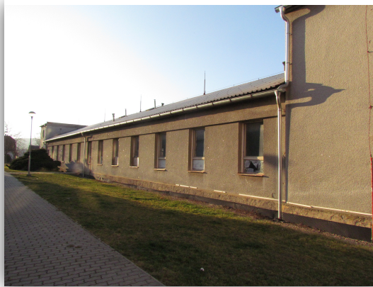
Obrázek č. 12: Budova - boční pohled
