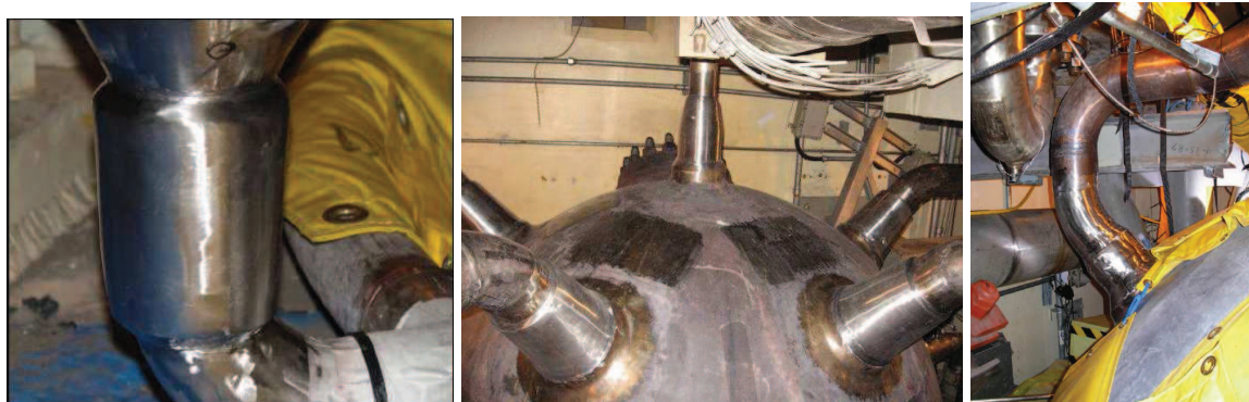
Obr. 1.4. Aplikace metody WOL na nátrubcích kompenzátoru objemu
