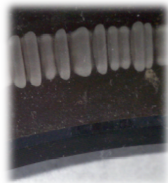
Obr. 3-5 Vnější kroužek poškozený ložiskovými proudy [29]
