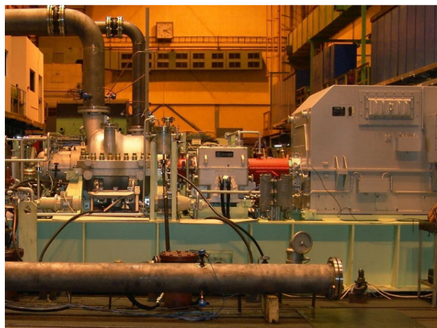
Obr. 2 – Kompresorová stanice tranzitního plynovodu s rychloběžnou převodovkou [5]
