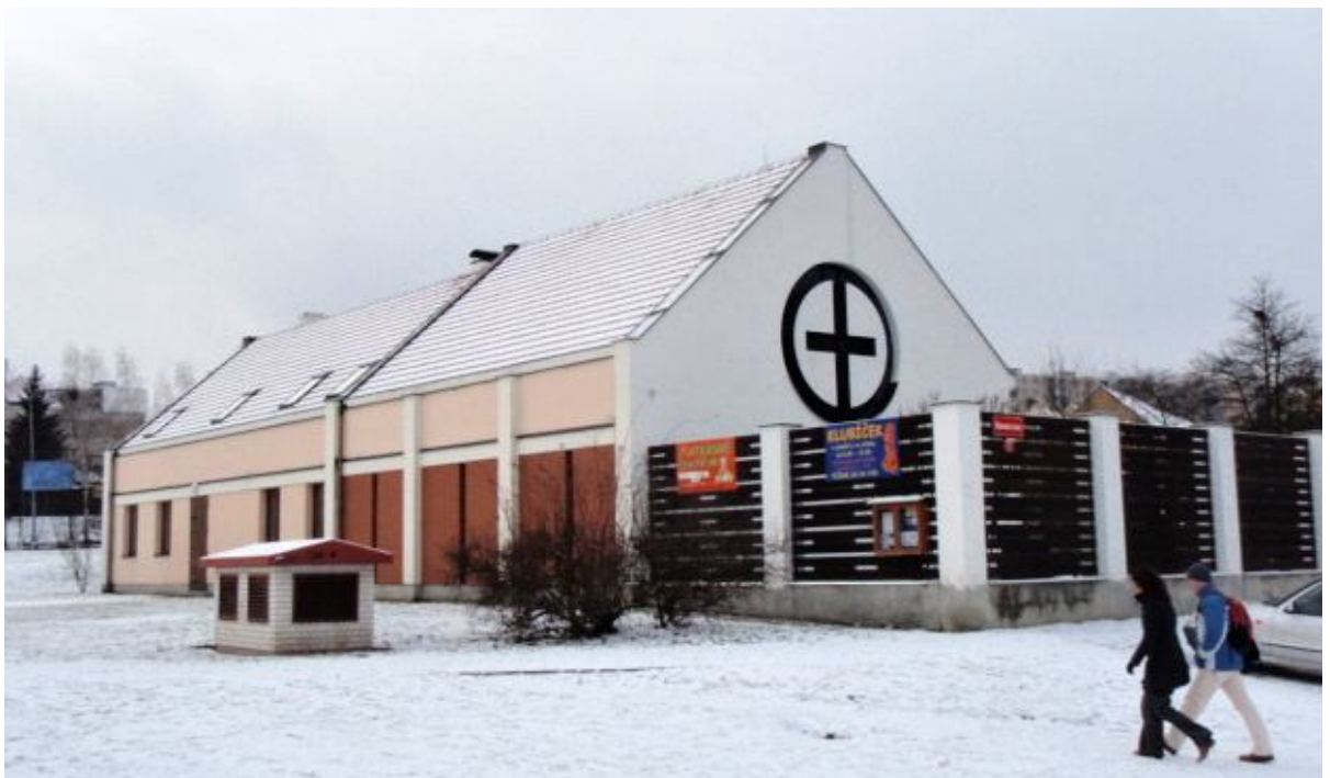
Příloha č. 5 – Kostel ECM na Lochotíně v Plzni, dostupné na WWW: http://www.ecmhyn.estranky.cz/fotoalbum/plzen/kostel-plzen-lochotin/
