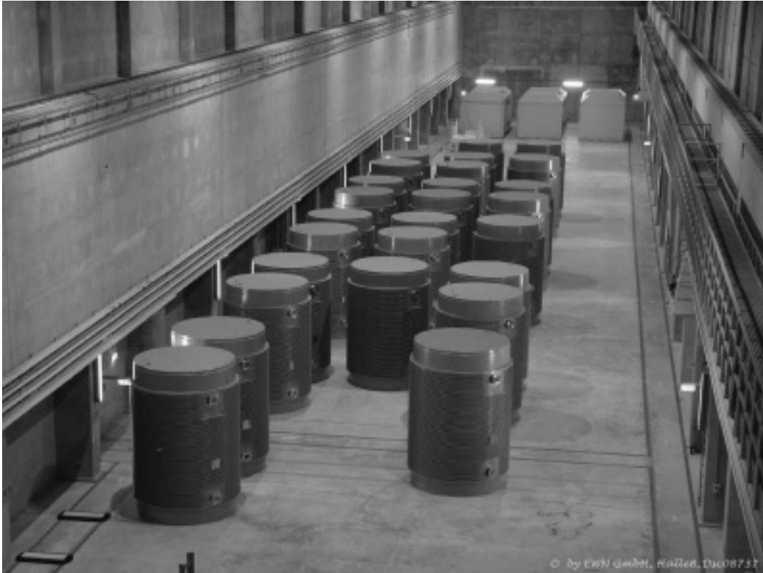
Obrázek 2.13: Krytý mezisklad vyhořelého paliva Jaslovské Bohunice
