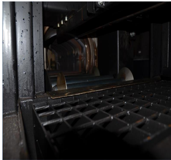
Obr.22 Dopravník mezi předkomorou a pecním zařízením
