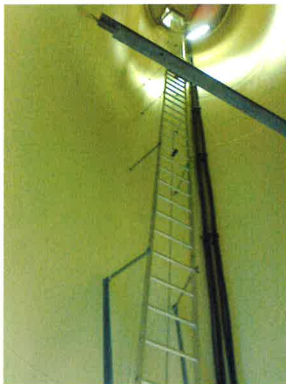
Obr. 4-2: Varianta bez servisního výtahu
