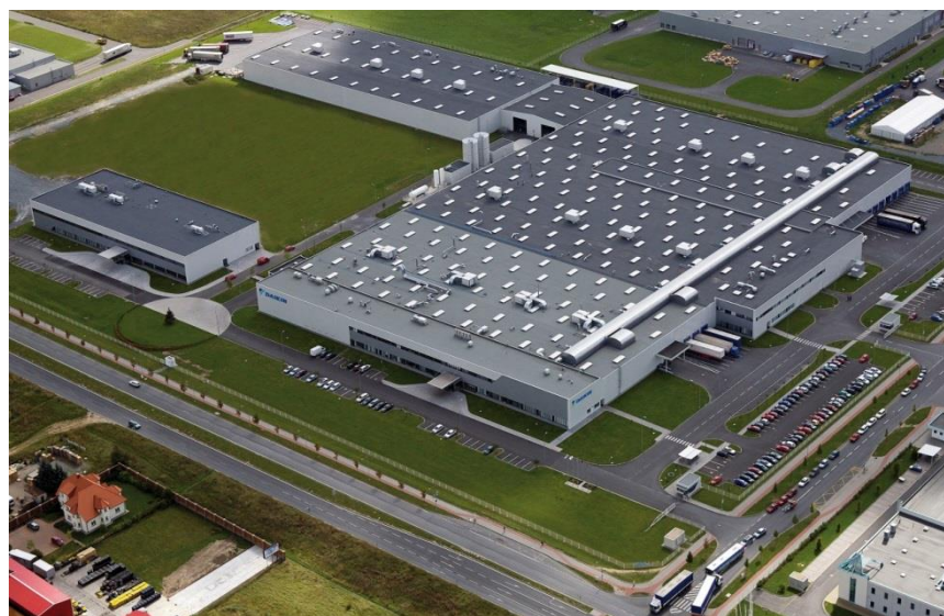
Fotografie 2: Firma Daikin 25
