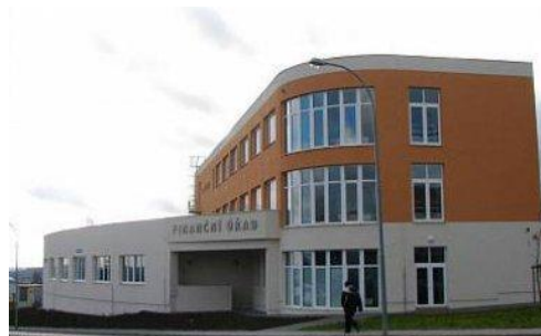
Finanční úřad v Tachově
