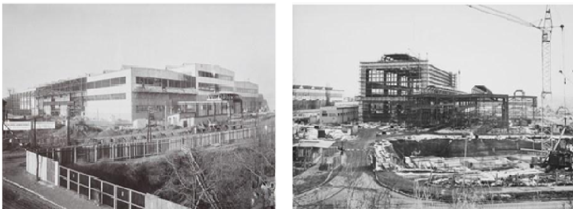
Obrázek č. 4 – Výstavba výrobní haly Gigant a Nové výrobní haly
