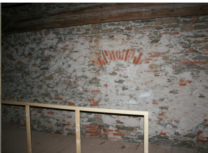
Obr. 27 Cihelný záklenkem v západním štítu krovu kostela sv. Anny (foto autorka).
