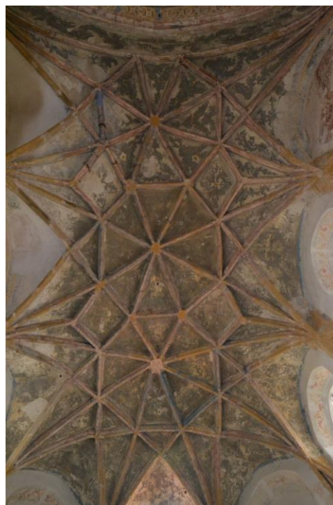
Obr. 23 Klenba presbytáře kostela sv. Anny na Vršíčku (foto autorka).
