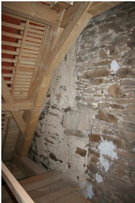
Obr. 28 Detail dozdvíky na severní straně východního štítu kostela sv. Anny (foto autorka).
