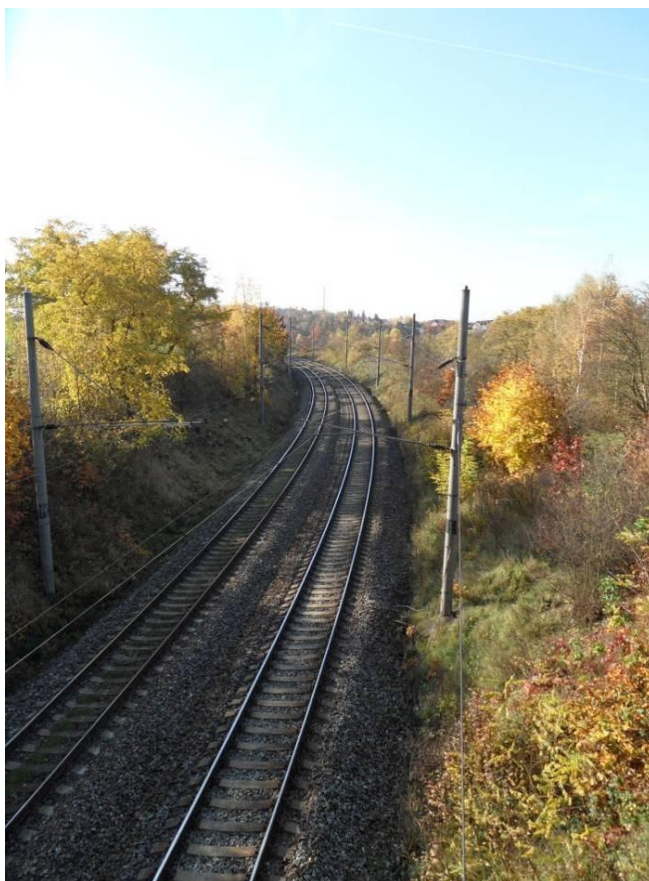
Příloha č. 20 - Železniční trať (Plzeň – Praha)
