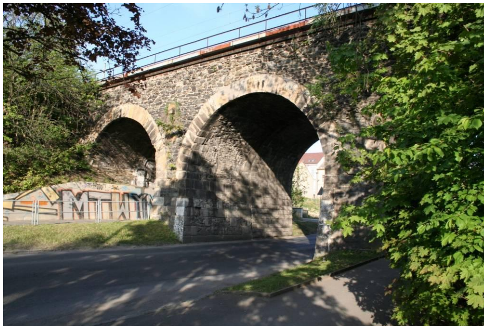
Příloha č. 34 - Podjezd v Mohylové ulici
