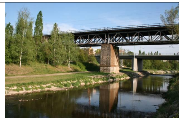
Železniční most dnes – stejný pohled Foto Jan Hajšman – soukromá sbírka, 3. 5. 2007
