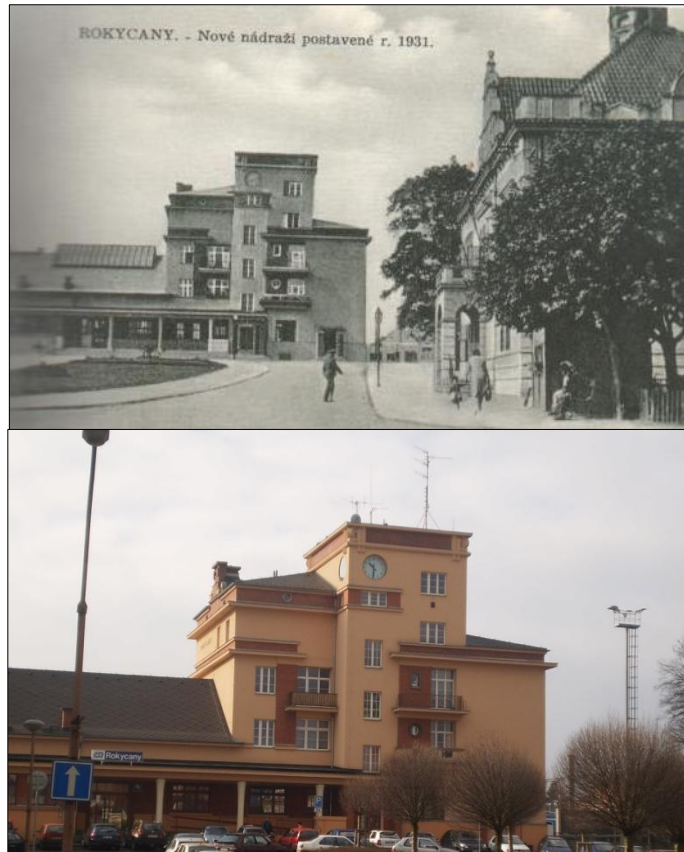
Obr. 15. Budova nádraží v roce 1932 a dnes
