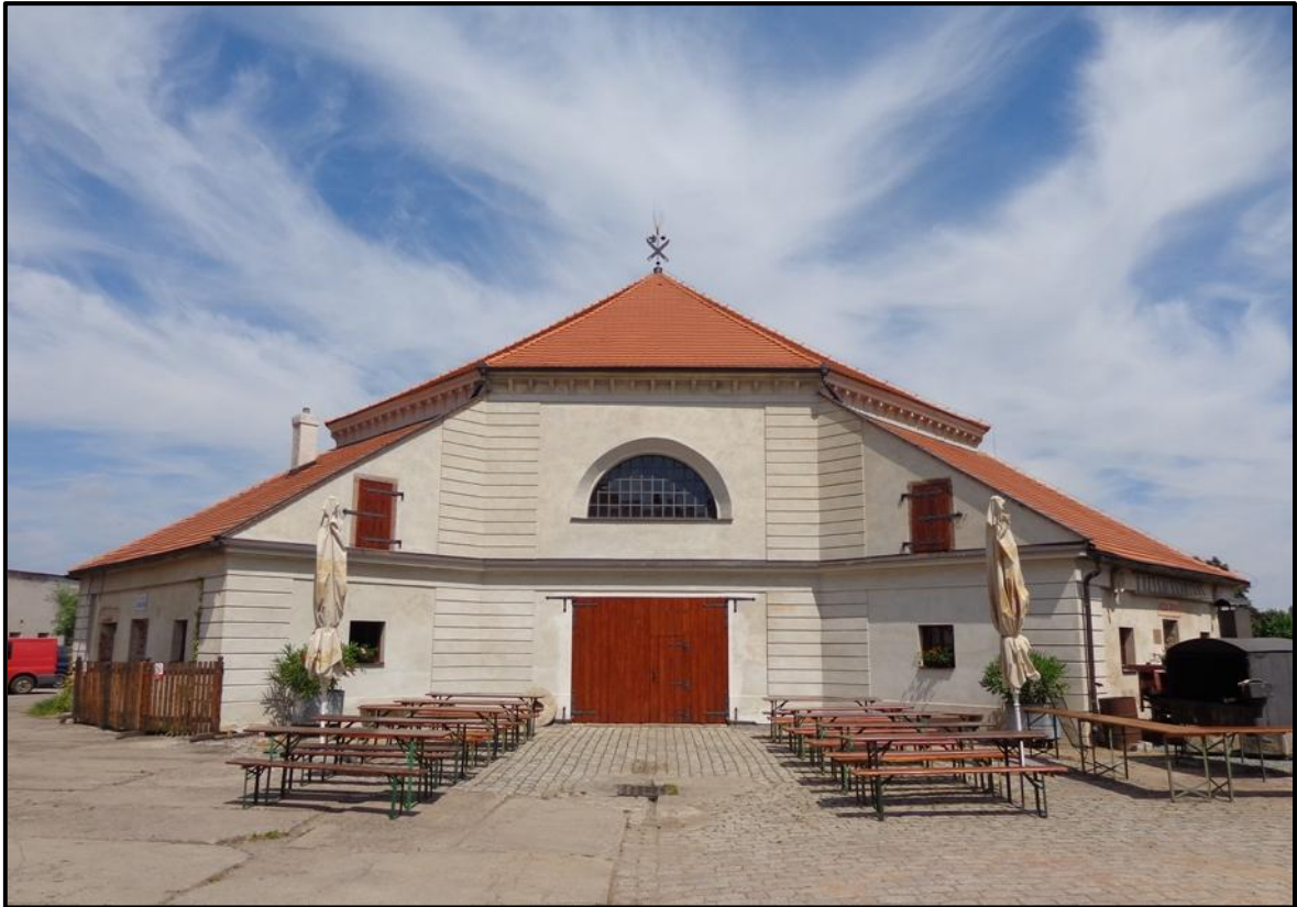
Obrázek 11: Žentourové mlýniště je památkově chráněná osmiboká budova s unikátním systémem krovu. Jedná se pravděpodobně o největší stavbu tohoto druhu v celé Evropě. Vnitřní průměr žentourového kola činil 17m a byl poháněn voly či koni. Po nákladné rekonstrukci slouží dnes tato budova především k pořádání kulturních akcí. Stav z června roku 2014. (Fotografie je uložena v soukromém archivu autorky této práce.)
