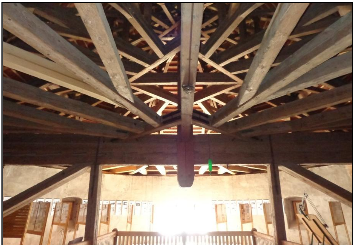
Obrázek 12: Unikátní samonosný krov v patře žentourového mlýniště. Stav z června roku 2014. (Fotografie je uložena v soukromém archivu autorky této práce.)
