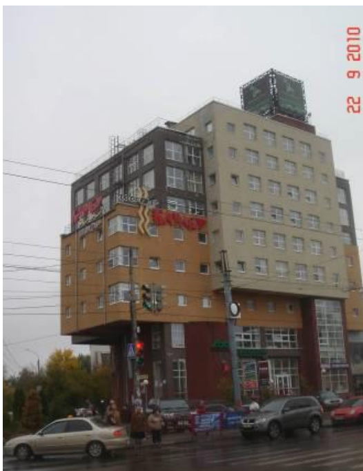
Obr. 21: Budova Teledom (Elizarova a kol. 2012).
