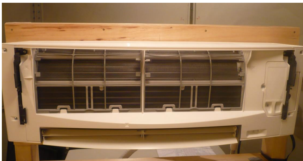
Obr.A2. Vnitřní nástěnná klimatizační jednotka bez předního panelu
