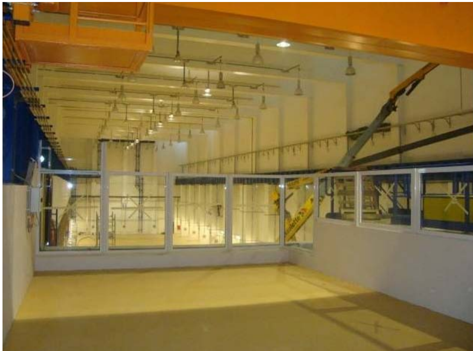
Obr. 2.5. Budovaný sklad v areálu JE Temelín o výměře 5 250m 2 [17].
