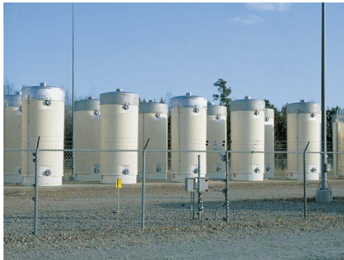
Obr. 2.3. Suché skladování v podobě betonových sil (USA) [10].
