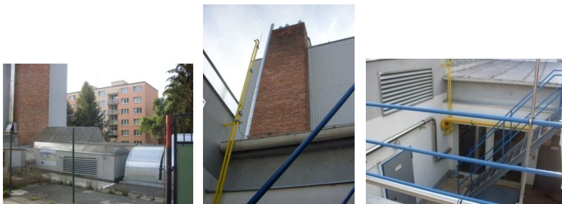
Obr. č. 27 : Kotelna v Husově ul. v Přešticích [vlastní foto]
