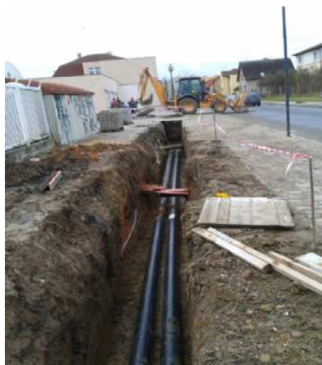
Obr. č. 26 : Realizace plynovodu [22]
