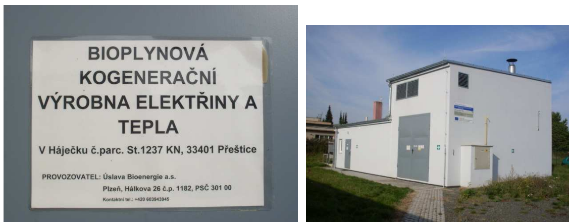
Obr. č. 31 : Bioteplárna v ulici V Háječku [vlastní foto]
